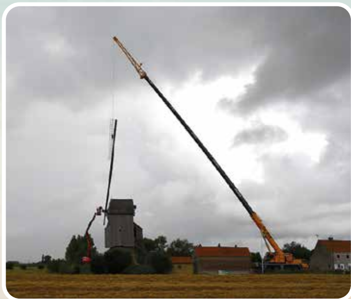
Démontage des ailes du Moulin Noordmeulen suite à la tempête Eunice
